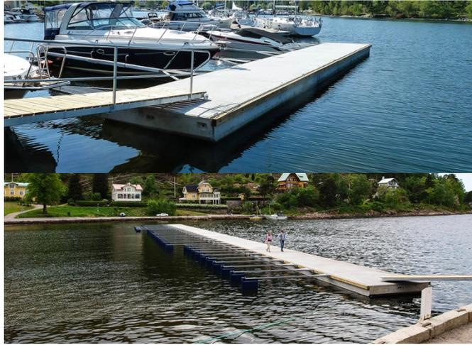
**Σχήμα 10** Προκατασκευασμένες πλωτές προβλήτες από οπλισμένο σκυρόδεμα.
