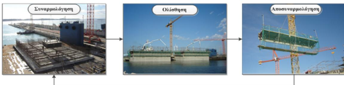
**Εικόνα 1** Κύκλος παραγωγής caisson
