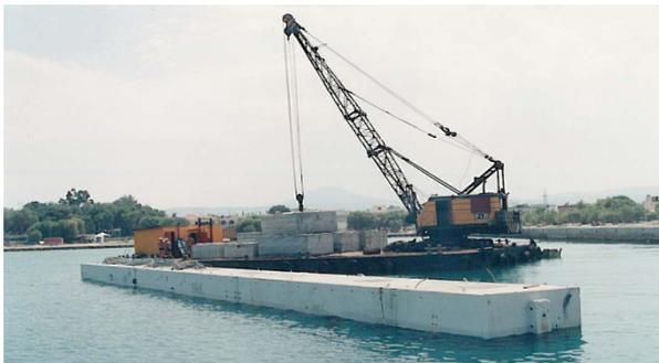
**Σχήμα 8** Πόντιση προκατασκευασμένου πλωτού κυματοθραύστη σε ιχθυοτροφείο
